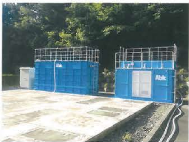
③設置完了
