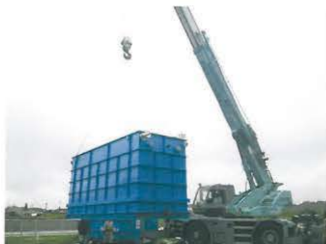
②クレーンにて吊込み
