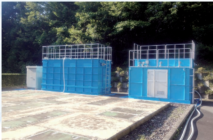
③設置完了
