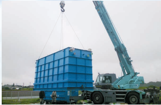
②クレーンで吊込み
