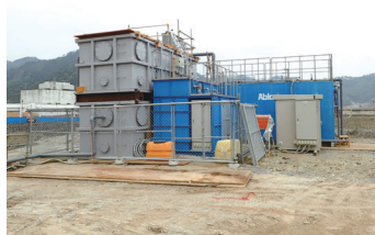
釜石市 U 町 被災下水道施設 建設工事中の仮設処理
