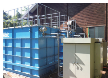
長野県 N 村の農業集落排水 施設改修工事における仮設対応
