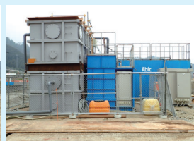
釜石市 U 町 2 災害対応仮設
