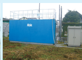
H 団地集合排水処理施設 機能強化仮設
