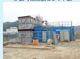
釜石市 U 町 1 災害対応仮設
