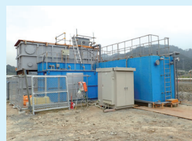
釜石市 U 町 3 災害対応仮設
