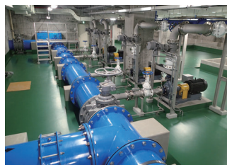
上水道プラント設備工事
