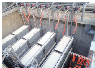
食品製造排水処理施設 (膜分離活性汚泥法 槽内膜ユニット)
