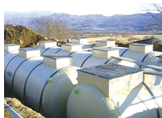
合併処理浄化槽工事
